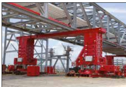
Циклическая навдвижка мостов
